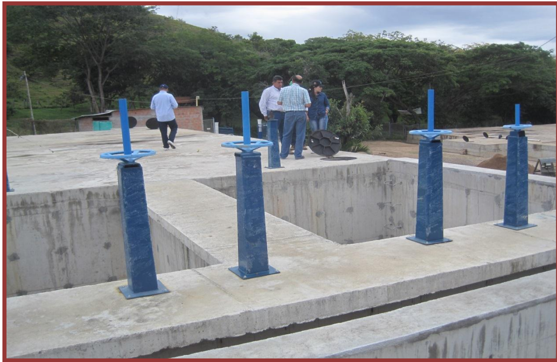
1 NUEVOS FILTROS-2 TANQUE ALMACENAMIENTO NUEVO 3300 M3 3 CAMARA CONTACTO CLORO NUEVA
