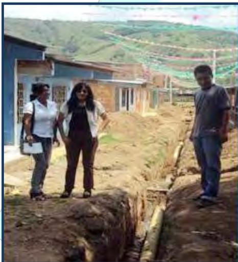
*Ampliación del Alcantarillado en un tramo de 186 metros de tubería de PVC de 8 pulgadas, en el barrio El Jardín, beneficiando a 43 familias suazeñas.*
