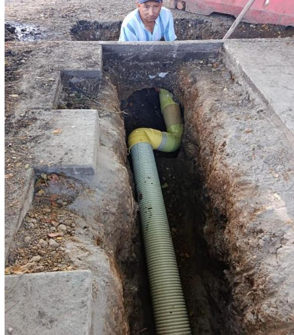
Se realizó la reposición del cabezal de descarga de la PTAR, el cual fue arrasado por una fuerte avalancha.
