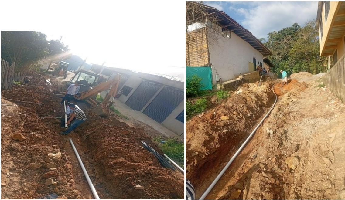
Se suministró e instaló tubería de 3" correspondiente a la aducción, en la vereda el Orozco, realizando el mejoramiento a travez de la reposición de la esistente.
