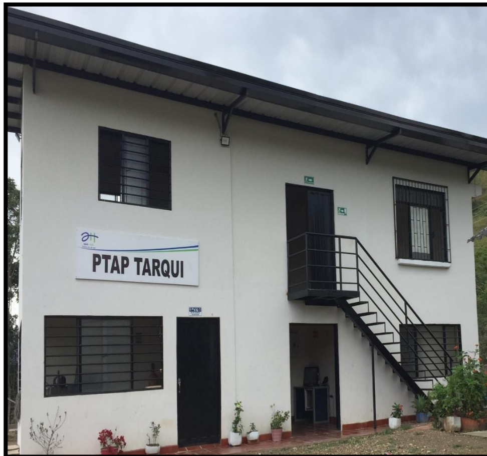
Figura 26 – Planta de tratamiento de agua potable casco urbano del Municipio de Tarqui
