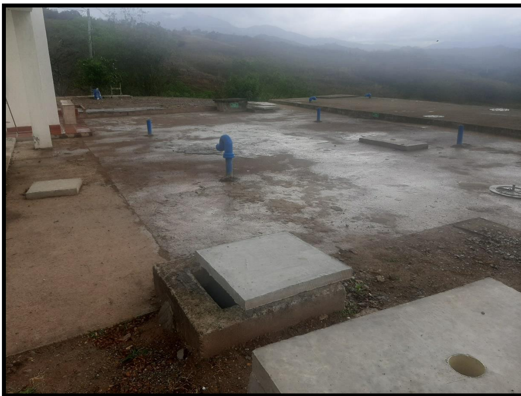
Figura 36 – Tanque de almacenamiento 2 acueducto del Municipio de Tarqui
