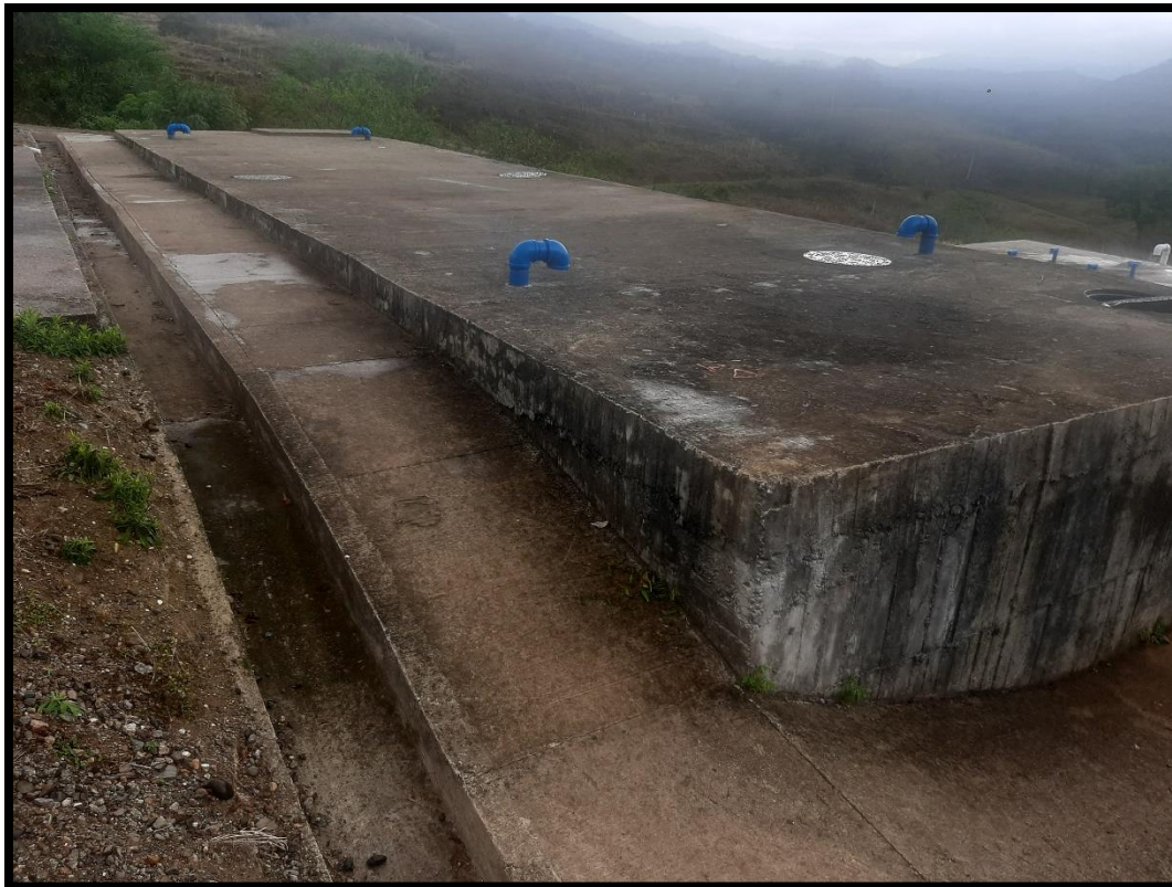
Figura 37 – Tanque de almacenamiento 3 acueducto del Municipio de Tarqui
