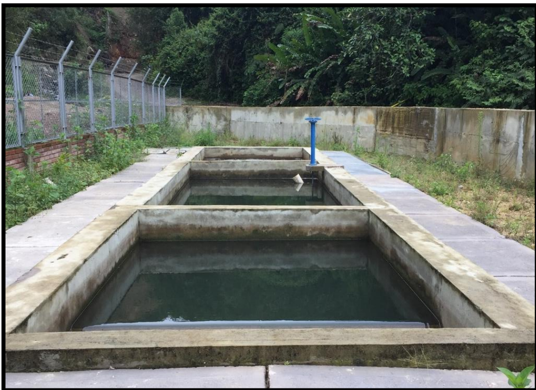
Figura 5 – Desarenador sobre aducción quebrada El Hígado
