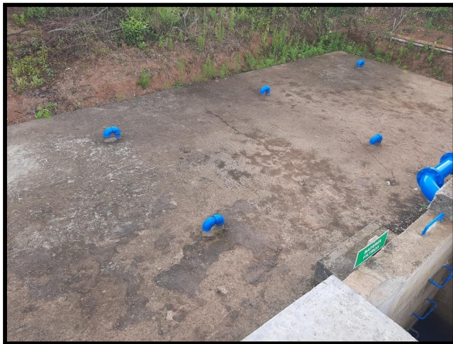
Figura 35 – Tanque de almacenamiento 1 acueducto del Municipio de Tarqui
