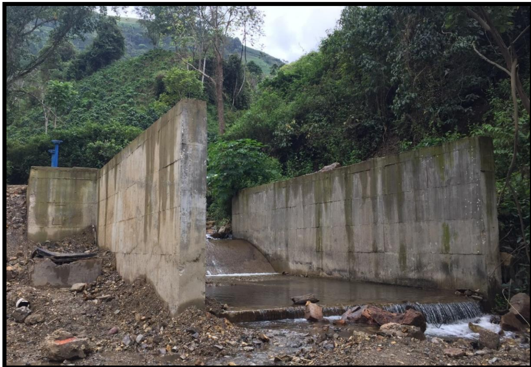
Figura 4 – Bocatoma sobre la quebrada El Hígado
