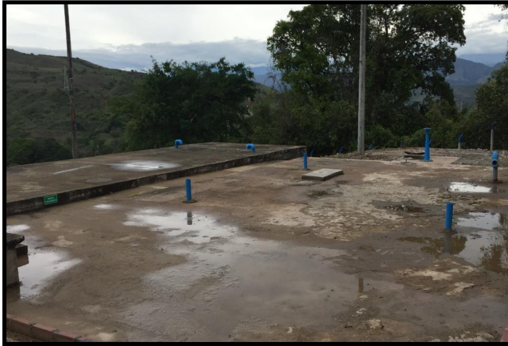
Figura 7 – Tanque de almacenamiento acueducto del Municipio de Tarqui
