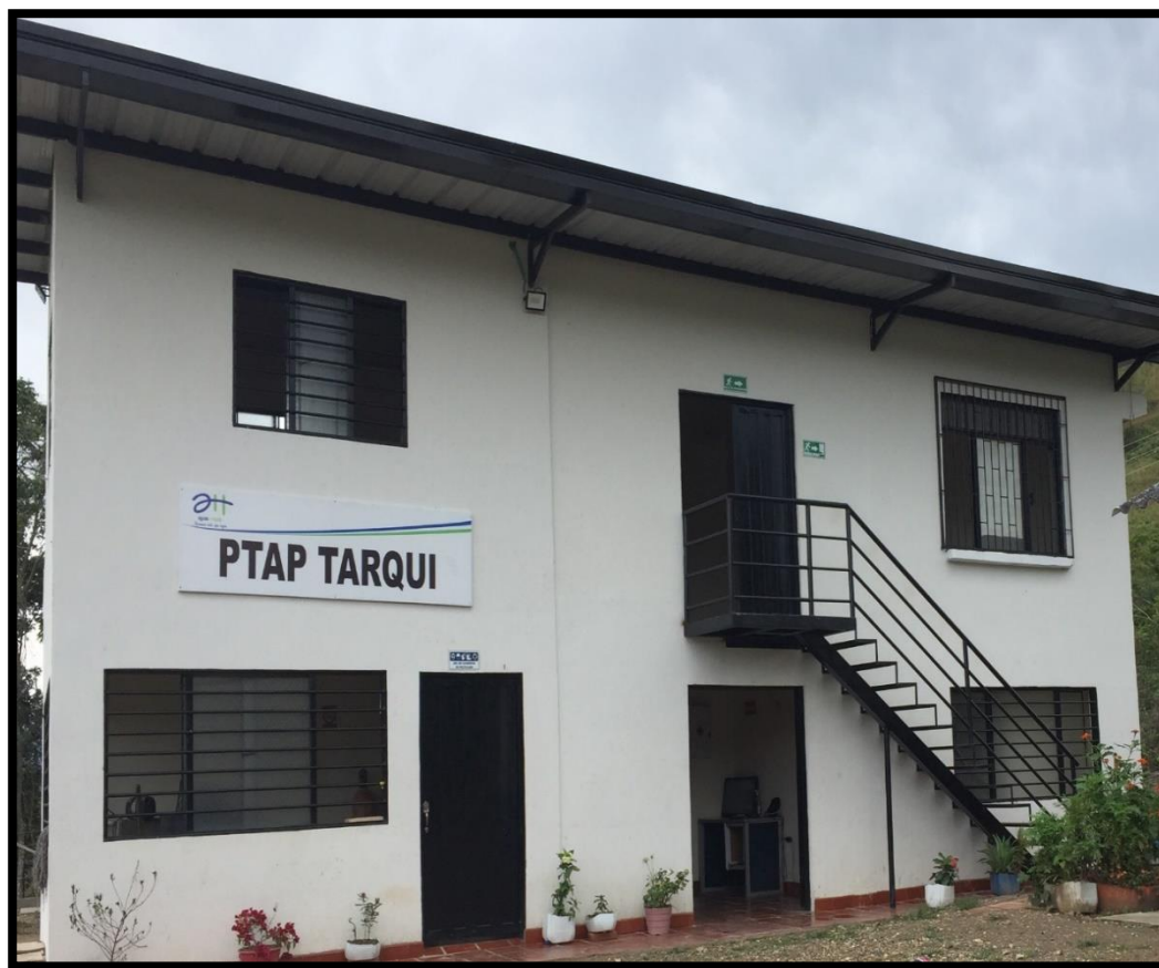
Figura 6 – Planta de tratamiento de agua potable casco urbano del Municipio de Tarqui
