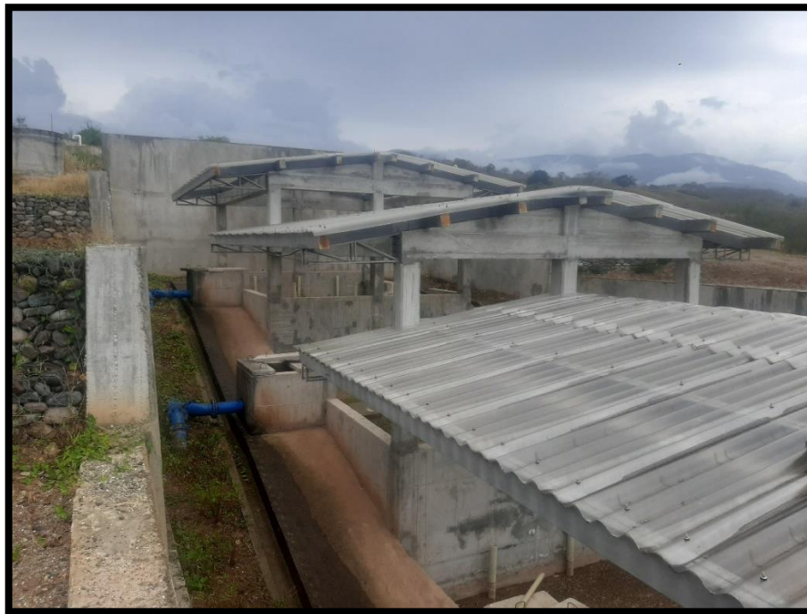
Figura 34 – Vista general de la batería de lechos de secado de lodos PTAP Tarqui
