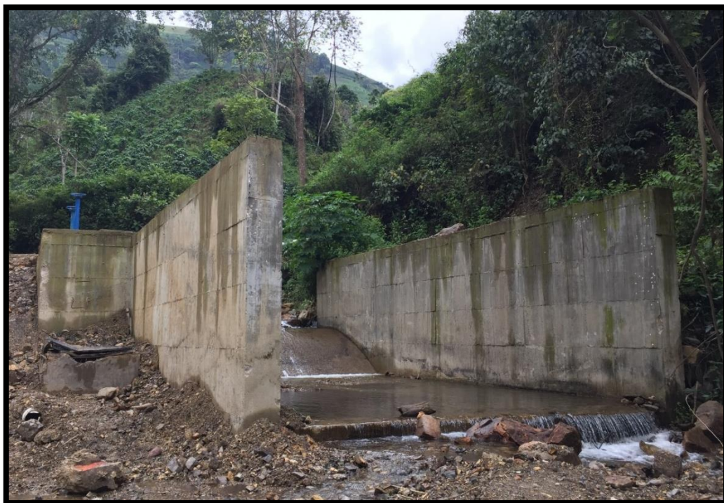
Figura 23 – Bocatoma sobre la quebrada El Hígado
