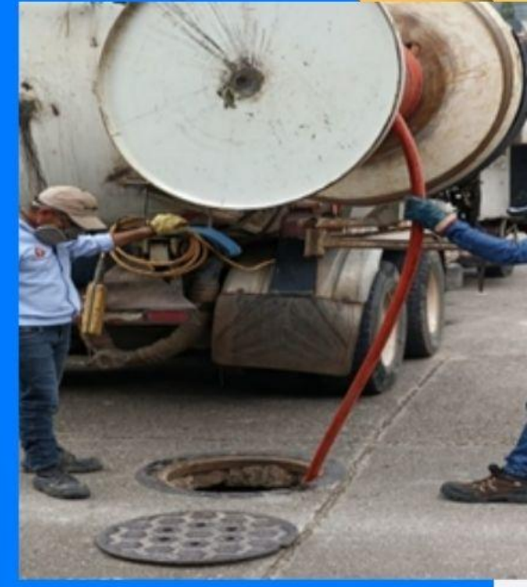
LIMPIEZA RED ALCANTARILLADO
